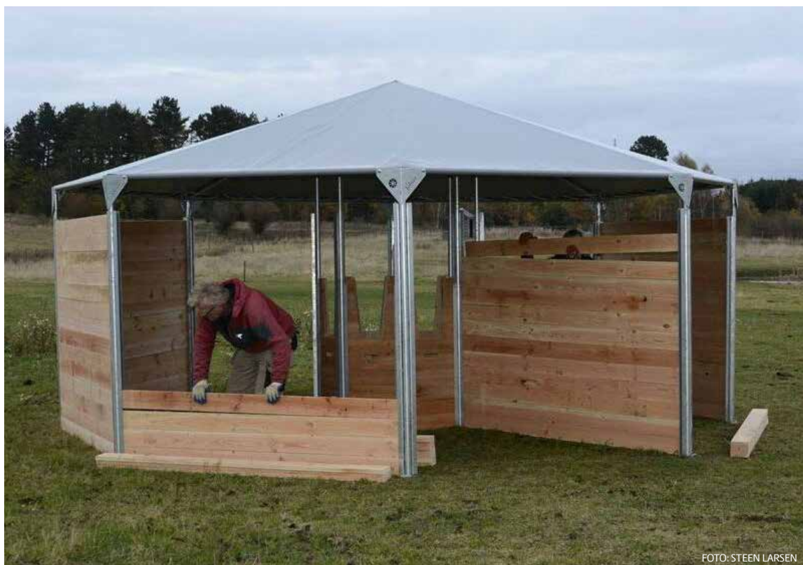
BILLEDE 34: Et fleksibelt læskur kan efter behov gøres mere eller mindre åbent ( www.jolner.dk ).
